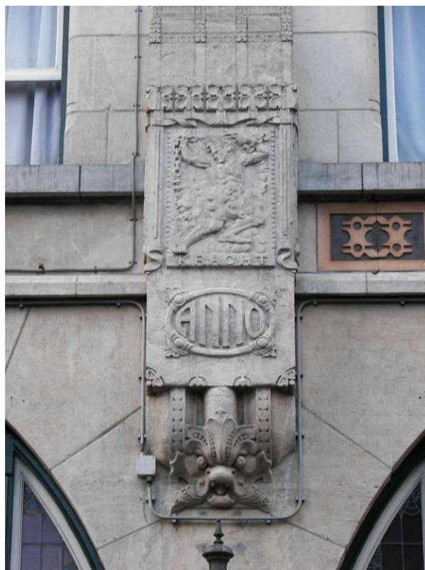
De pilaster met gevelsculptuur KRACHT verbeeld als man met ketting, er onder ANNO .
