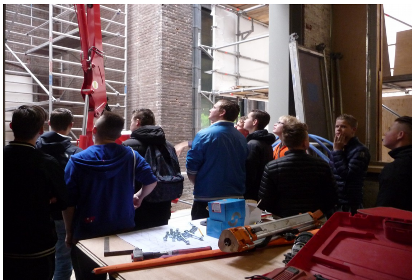
Afbeelding 1: leerlingen kijken toe hoe een element op zijn plaats wordt gehesen en gesteld
