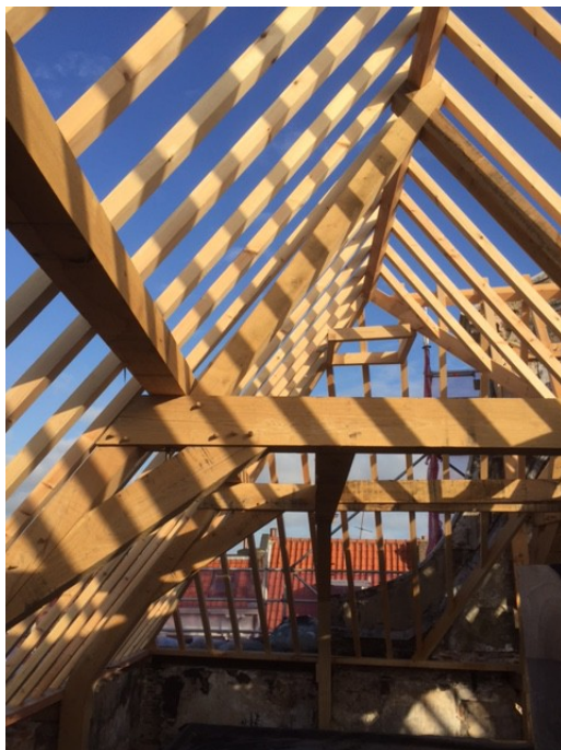
Afbeelding 1: De nieuwe kapconstructie
