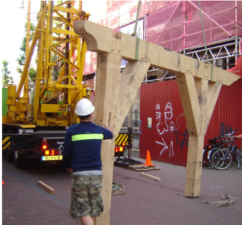
Afbeelding 3: vastsjorren voor het hijsen van het houten juk
