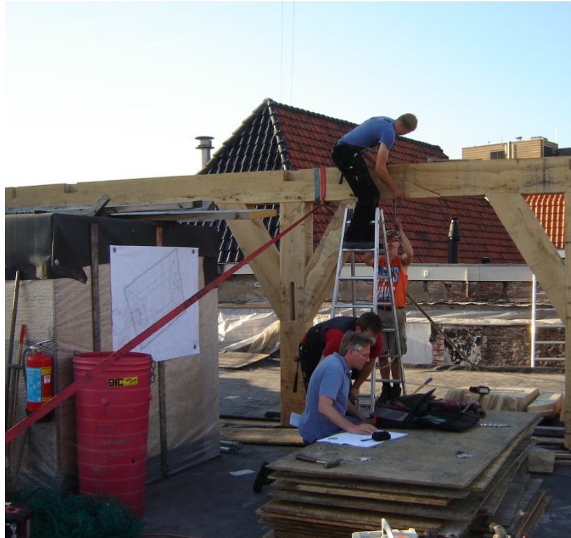
Afbeelding 5: aan elkaar koppelen van de jukken, die rondom het verhoogde binnendeel van de zadeldaken staan
