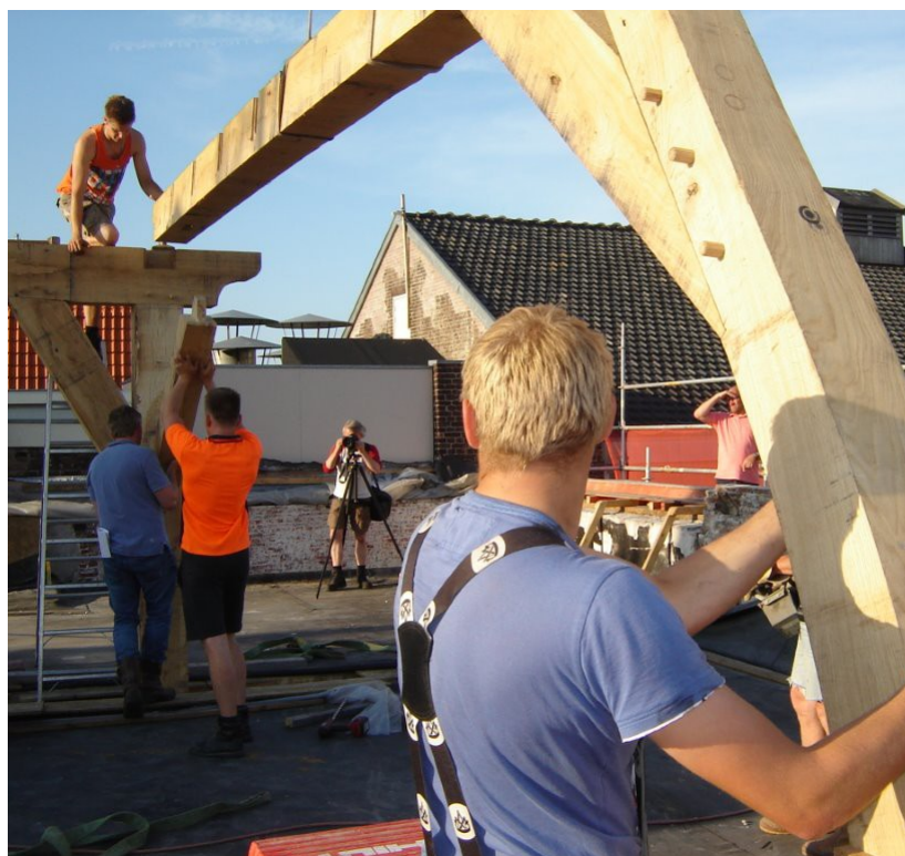
Afbeelding 6: halve kopsant wordt gekoppeld aan en opgelegd op het houten juk
